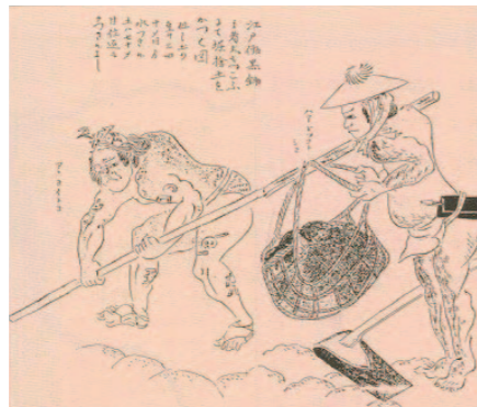
工事のようす(続保定記より)
